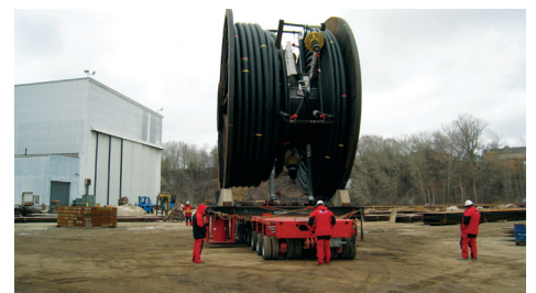
Dois carretéis de 9.2-m com dutos
